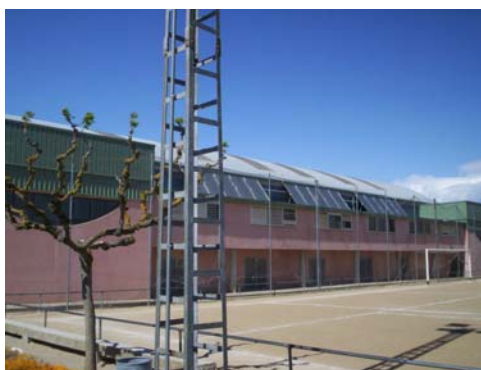
Equipaments municipals amb energia solar
